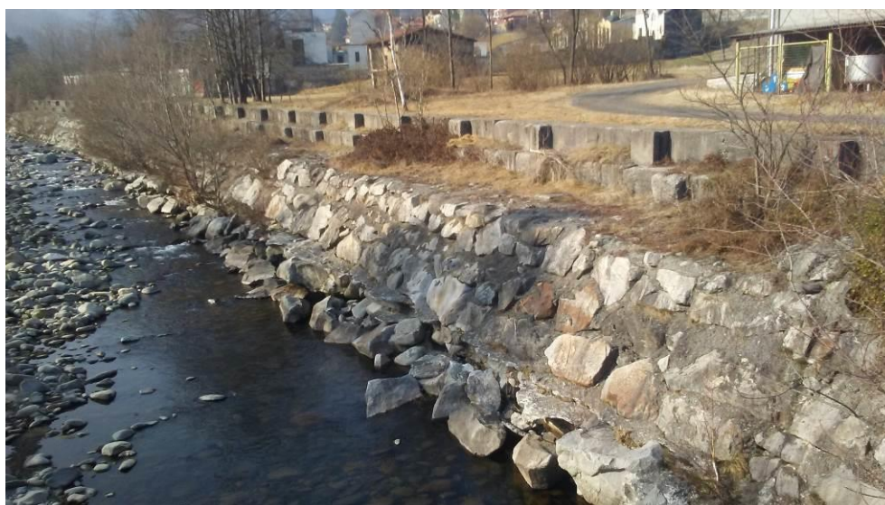
Figura 24 - - Sottoescavazione delle scogliere poste a protezione della sponda in sinistra idraulica, a valle del cimitero di Coggiola
