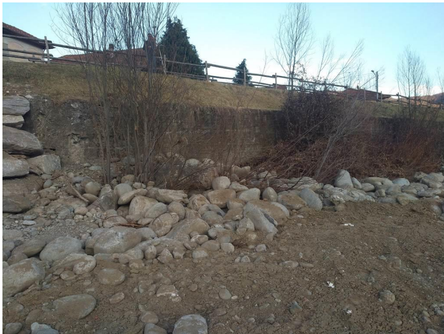
Figura 19 - Muro esistente in sinistra idrografica circa 220 m a valle del ponte di via Molino, in Comune di Pray che presenta problematiche di protezione al piede
