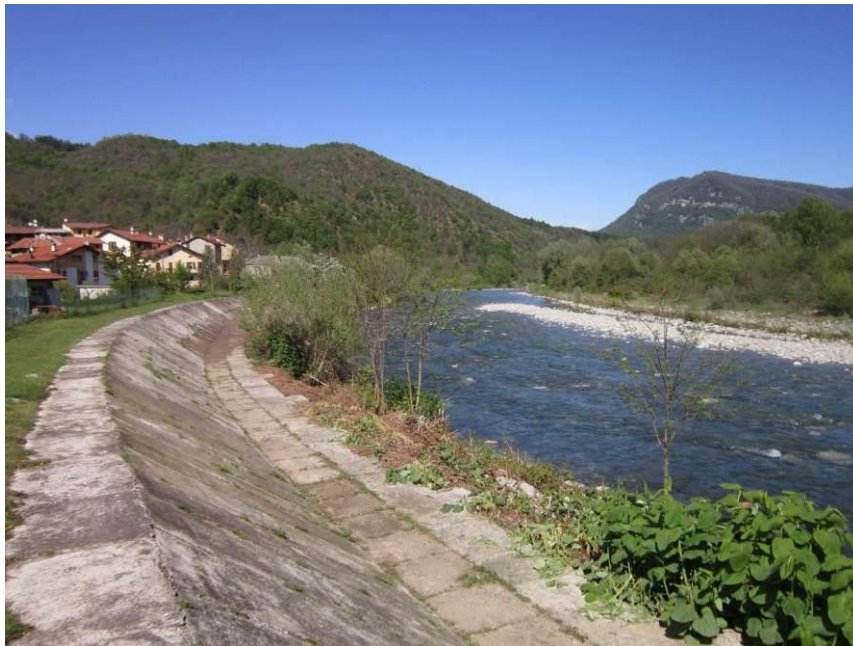
Figura 7 - Arginatura nel tratto più a monte a protezione della Guardella dalle esondazioni del Sessera
