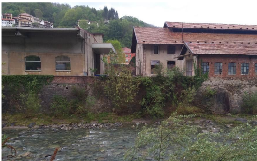
Figura 47 – Stabilimento in sinistra idraulica con muretto di protezione sormontato dai livelli idrici del Sessera in occasione di eventi di piena parossistici
