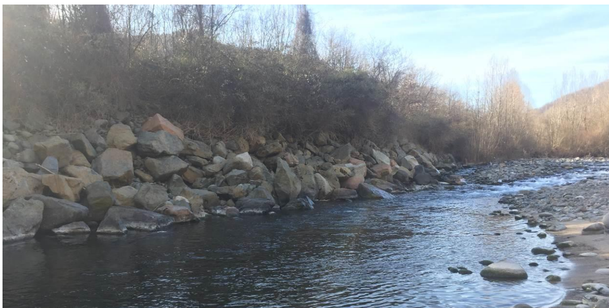
Figura 15 – Rampa naturale in ciottoli e massi e tendenza dell'alveo alla battuta in corrispondenza della pk 1+485 – vista da valle
