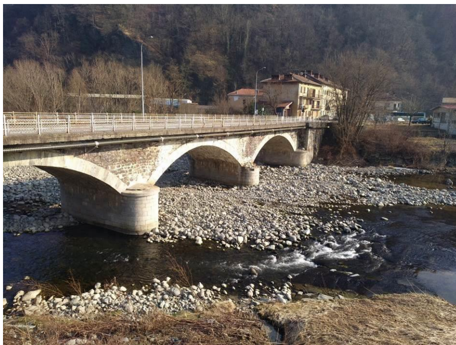
Figura 29 – Ponte di Pianceri visto da monte per il quale si prevede la realizzazione della quarta campata in destra idraulica
