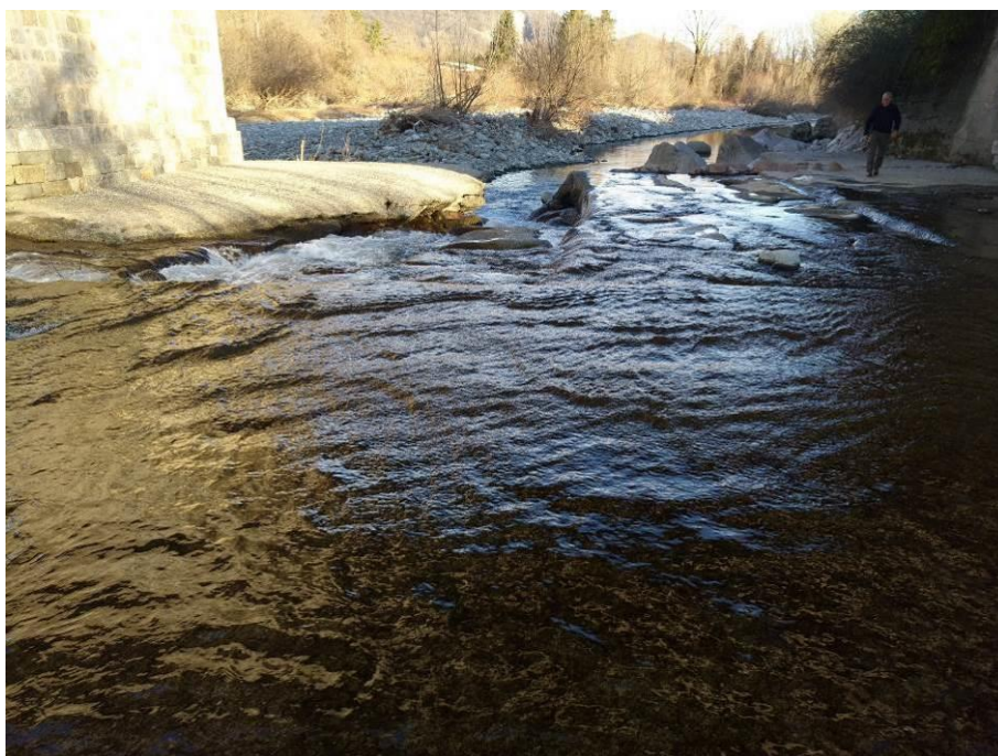
Figura 10 – Ammaloramento della soglia in corrispondenza della pila destra del ponte di Borgosesia
