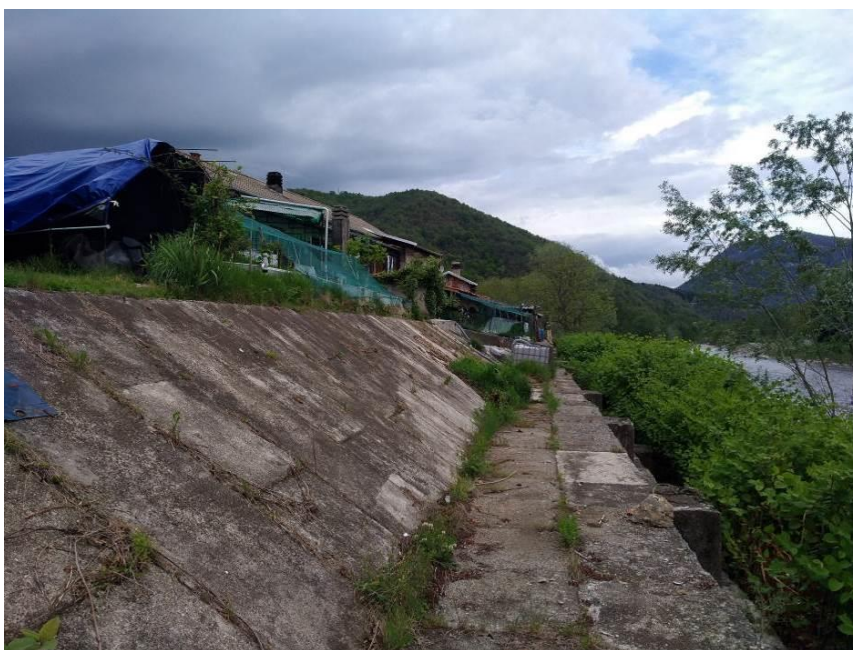
Figura 8 - Interruzione dell'argine a protezione ed abitazioni aggettanti verso l'alveo interessate dalle dinamiche di esondazione del Sessera
