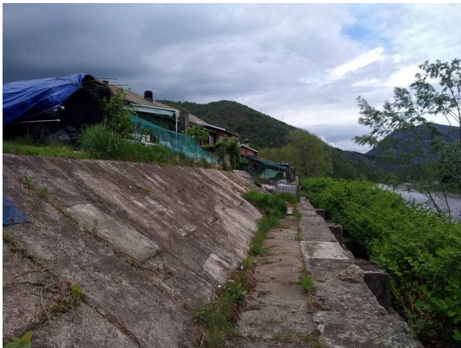
Figura 18 - Interruzione dell'argine a protezione della Guardella ed abitazioni aggettanti verso l'alveo interessate dalle dinamiche di esondazione del Sessera
