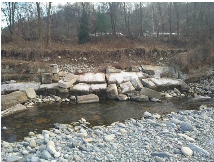
Figura 32 – Opere di protezione completamente abbattute dalla corrente per le quali si rende necessario il completo ripristino
