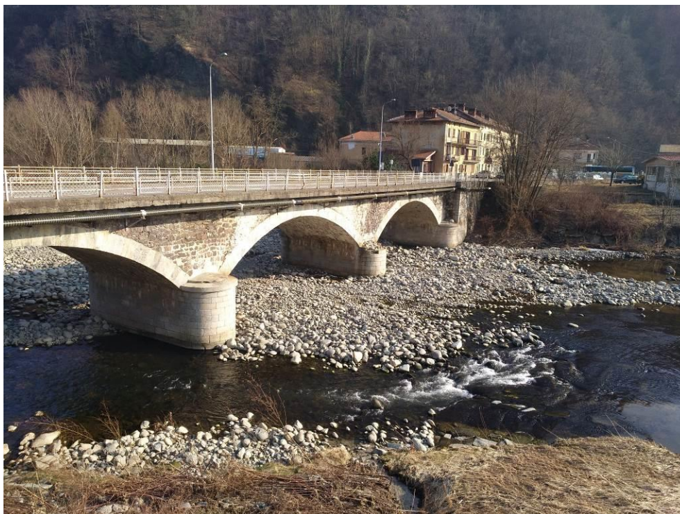
Figura 15 - Ponte di Pianceri visto da monte per il quale si prevede la realizzazione della quarta campata in destra idraulica
