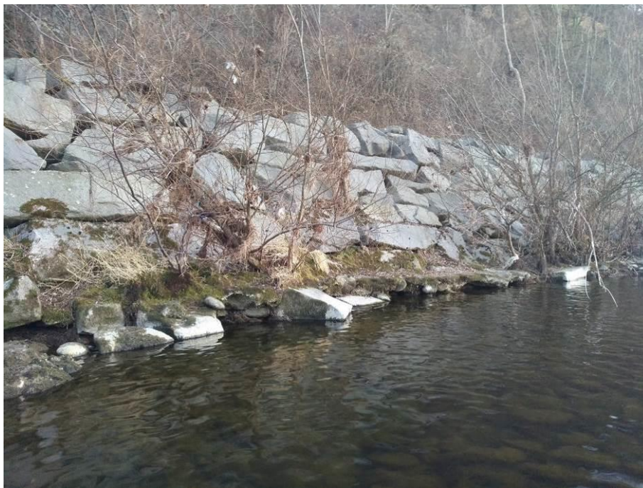
Figura 20 – Scogliera a ridosso della galleria della SP 71 con evidenti segni di erosione al piede
