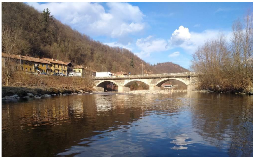
Figura 59 – Ponte di Pianceri visto da monte. Dall'immagine è possibile evincere il restringimento di sezione in destra per la realizzazione della spalla e la possibilità di realizzare una quarta campata
