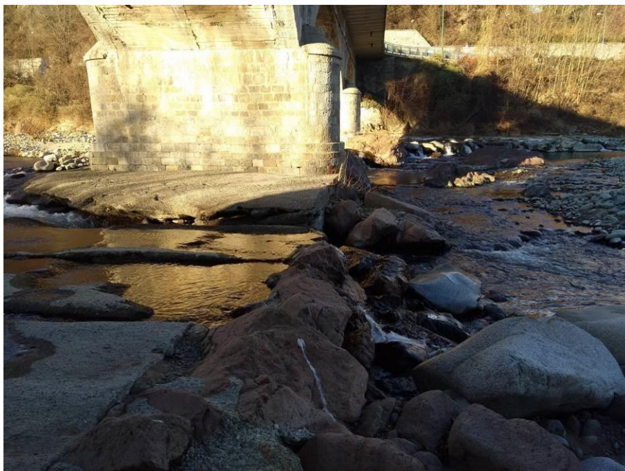
Figura 9 – Incisione in corrispondenza della soglia del ponte di Bornate
