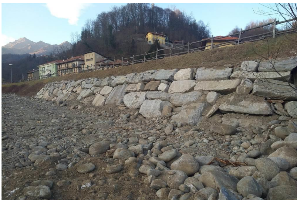
Figura 20 – Scogliera in massi ciclopici adiacente al muro esistente in c.a.
