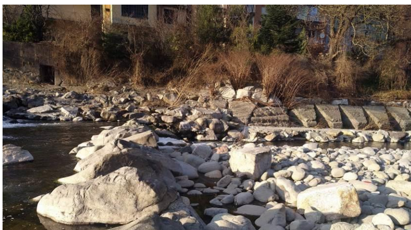
Figura 23 – Blocchi in cls a protezione della sponda sinistra a valle della traversa di sostegno del ponte di Pianceri interessati da fenomeni di escavazione al piede
