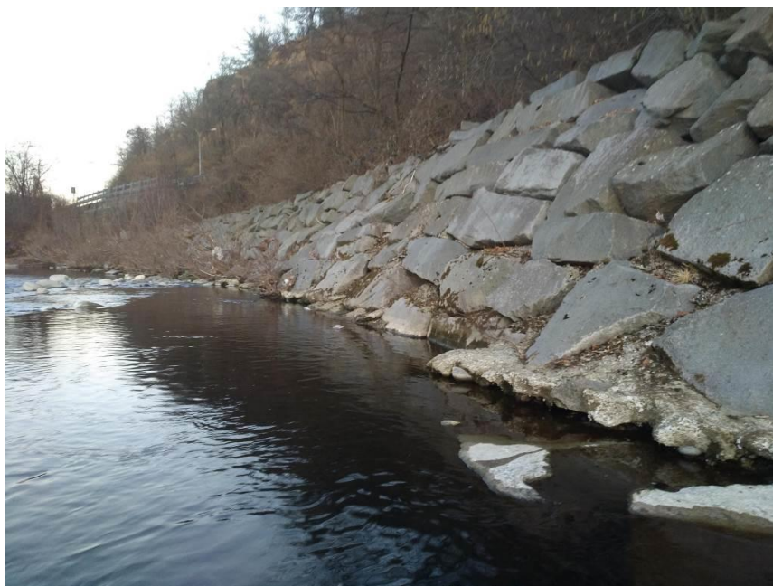
Figura 12 - Scogliera a ridosso della galleria della SP 71 con evidenti segni di erosione al piede
