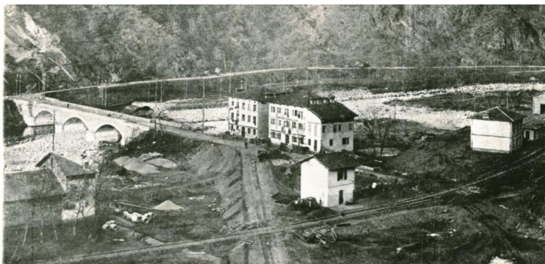
Figura 25 – Formazione di rilevato in destra idraulica a chiusura parziale della sezione di deflusso del Sessera a ridosso del quale è stata realizzata la spalla destra dell'attraversamento
