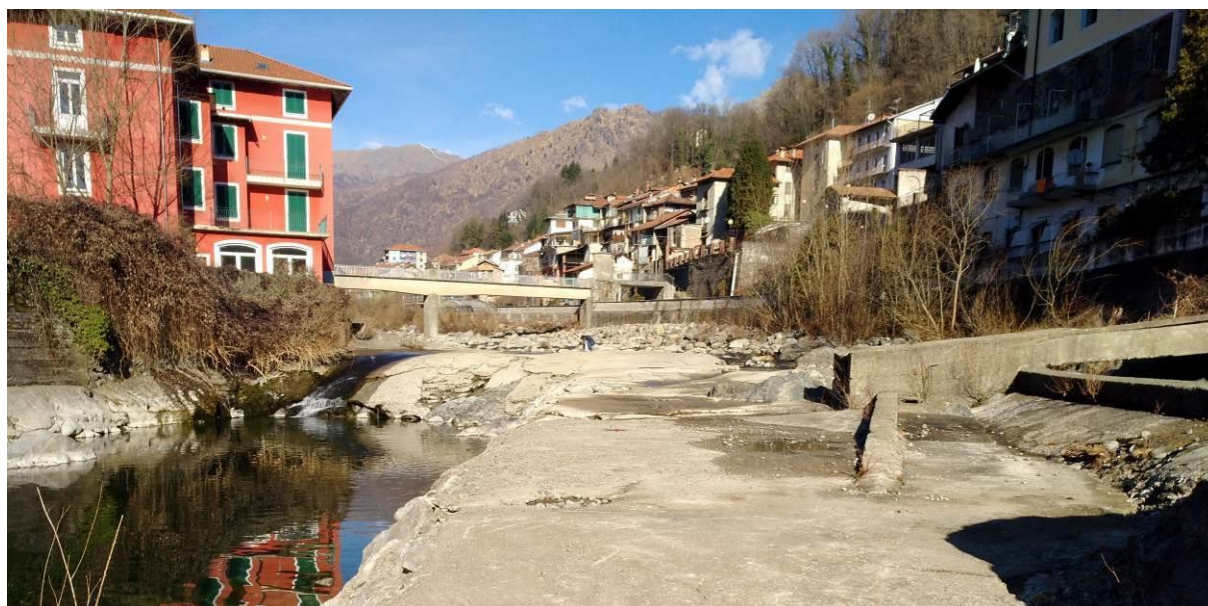
Figura 42 – Vista da valle della traversa in alveo, dell'edificio a parziale ostruzione della sezione d'alveo (condominio rosso), della passerella pedonale e dei muri di sponda a protezione di via della Libertà
