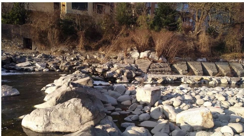
Figura 14 - Blocchi in cls a protezione della sponda sinistra a valle della traversa di sostegno del ponte di Pianceri oggetto di escavazione al piede
