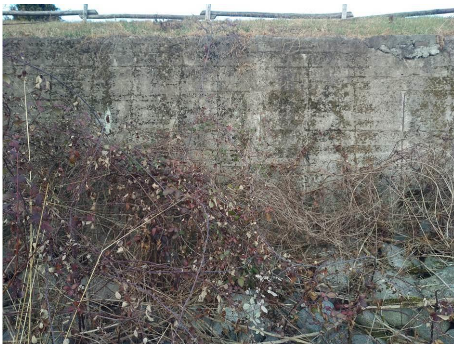
Figura 30 – Muro esistente in sinistra idrografica circa 220 m a valle del ponte di via Molino, in Comune di Pray che presenta problematiche di protezione al piede
