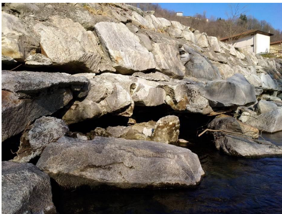
Figura 34 – Sottoescavazione delle scogliere poste a protezione della sponda in sinistra idraulica, a valle del cimitero di Coggiola
