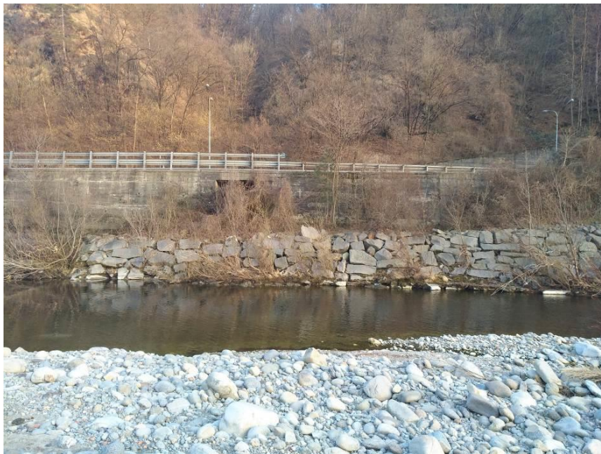
Figura 11 - Scogliera a ridosso della galleria della SP 71 con evidenti segni di erosione al piede
