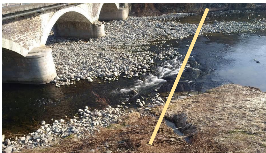
Figura 27 – Tracciato della condotta Co.R.D.A.R. immersa nella soglia a monte del ponte di Pianceri
