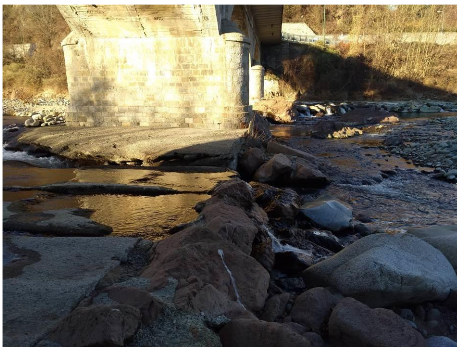
Figura 2 - Incisione in corrispondenza della soglia del ponte di Bornate
