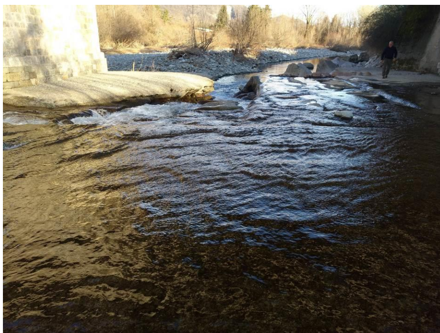
Figura 3 - Ammaloramento della soglia in corrispondenza della pila destra del ponte di Borgosesia
