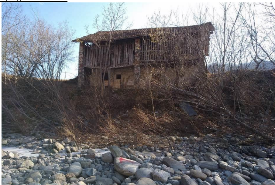
Figura 35 – Edificio insistente sulla sponda destra in prossimità della pk 9+900 in condizioni di abbandono e pericolosa precarietà, che potrebbe essere soggetta a erosione al piede e collasso in condizioni di piena
